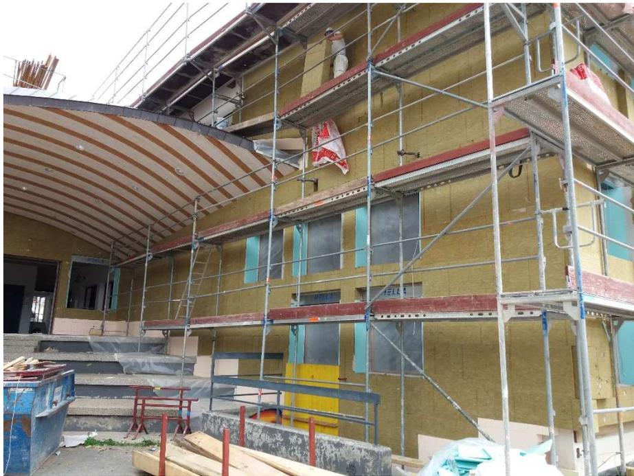
**Abbildung 5: Anbringen der Außendämmung an der Fassade**
