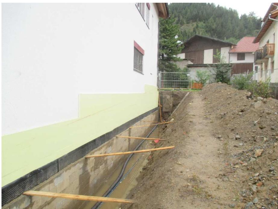
**Abbildung 4: Grabungsarbeiten und Anbringung der Dämmung Kellergeschoss**
