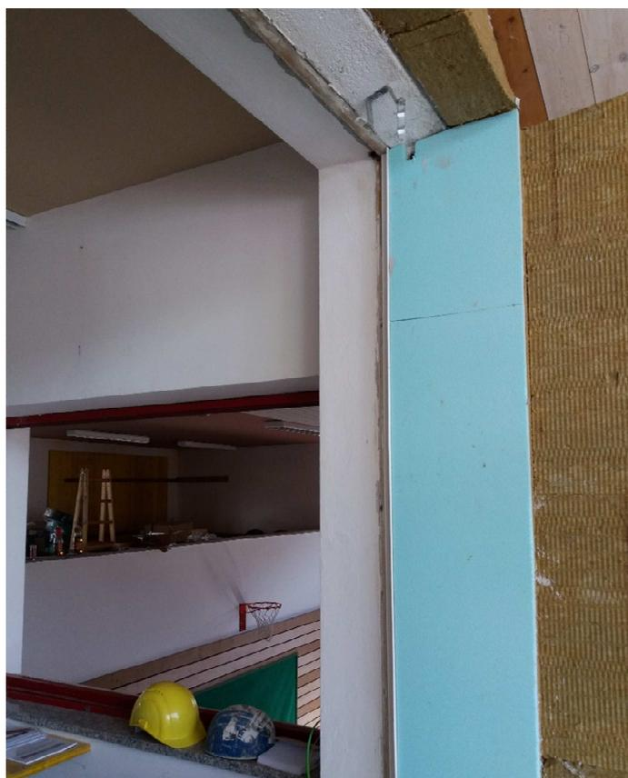
**Abbildung 8: Dämmung der Fensterleibungen**
