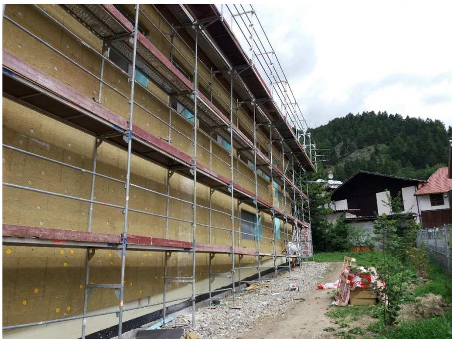
**Abbildung 6: Anbringen der Außendämmung Ostseite**
