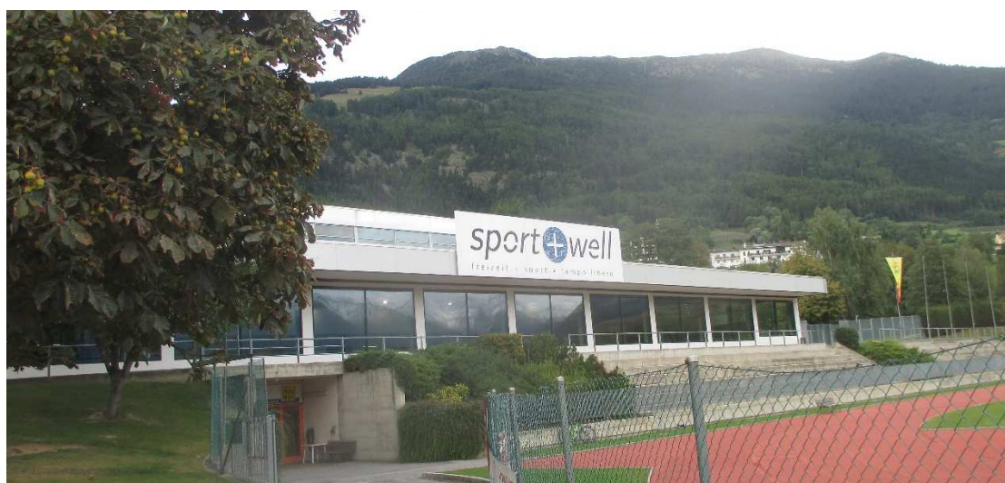
Abbildung 2: Südfassade Sport- und Wellnesscenter
